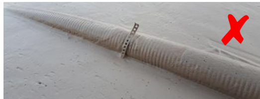
Betonnagels i.p.v. pluggen:
